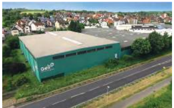
Geli-Verwaltung und -Produktion in Alzenau Geli administration and production in Alzenau
